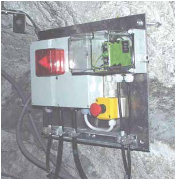
Abb.: die Kompakt-Blitzleuchte PY X-S-05 im Tunneleinsatz, Eingangsspannungsbereich: 70–264 V AC / 73–140 V DC (Netz/Batterie)
