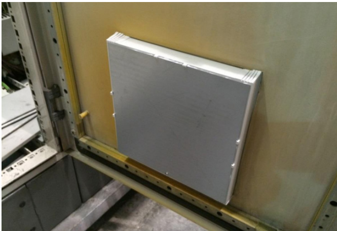
Die Filterlüfter von Pfannenberg sind abgedichtet eingesetzt, sodass keine Luftzufuhr möglich ist.
