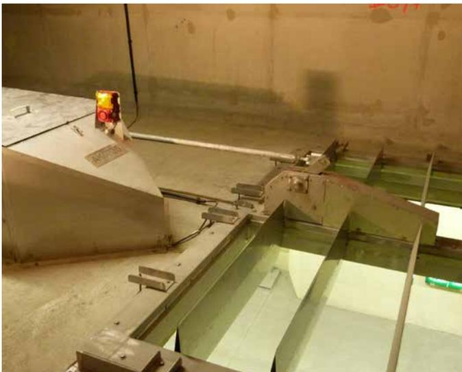
Geöffnete Lüftungsklappe im Gleinalmtunnel mit Blick in die darunterliegende Verkehrsröhre. In den beiden Abluftkanälen sind je rund 80 Lüftungsklappen verbaut, die im Brandfall auch der gesteuerten Rauchabsaugung dienen.
