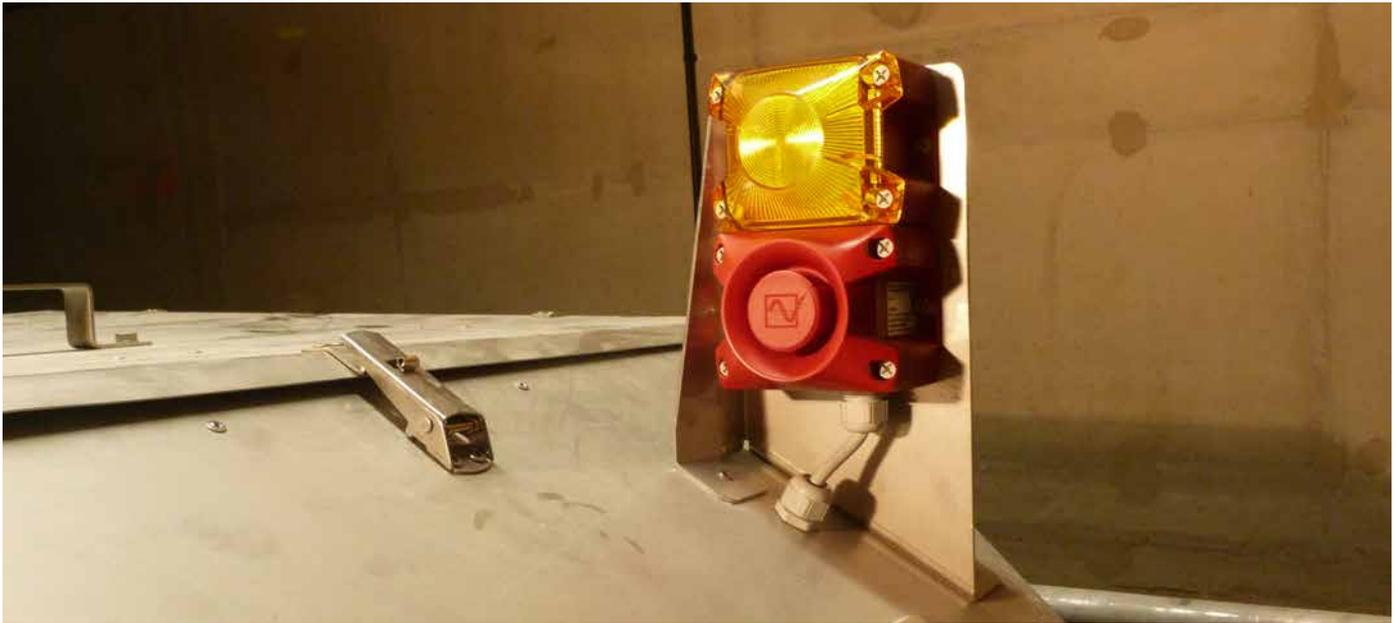
Im voll ausgebauten Gleinalmtunnel sorgen 160 Blitzschallgeber PA X 1-05 mit einer Blitzfrequenz von 1 Hz aus der PATROL-Serie von Pfannenberg für eine zuverlässige Brandalarmierung in den Abluftkanälen.
