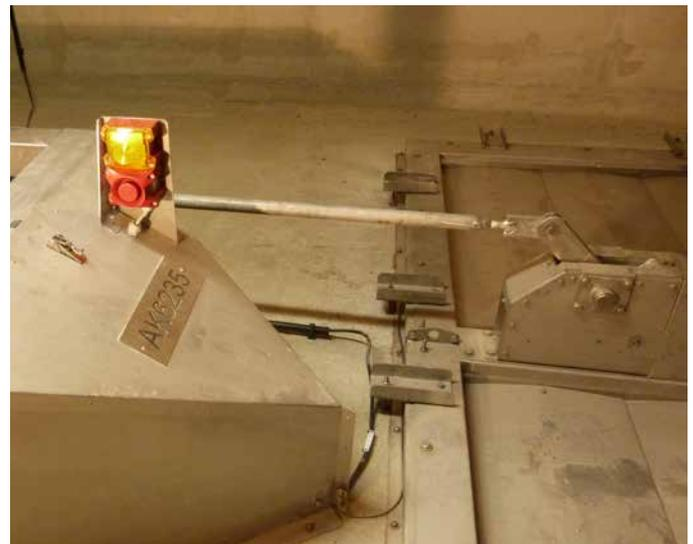
Über die gesamte Tunnellänge ist alle 100 Meter jeweils eine Belüftungsklappe in den beiden Abluftkanälen installiert. Im Brandfall erfolgt die optische und akustische Alarmierung über die Pfannenberg-Signalgeräte. Erst nach der bestätigten Räumung darf die Rauchabsaugung gestartet werden.
