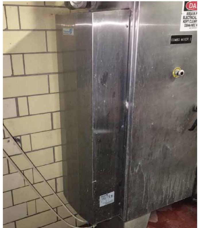
Bild4: PWS-Wärmetauscher am Schaltschrank angebaut
