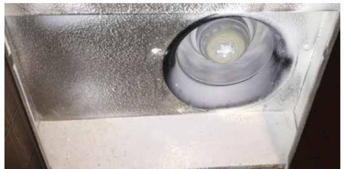
Bild2: Mehl- und Staubablagerungen im vorhandenen Kühlgerät
