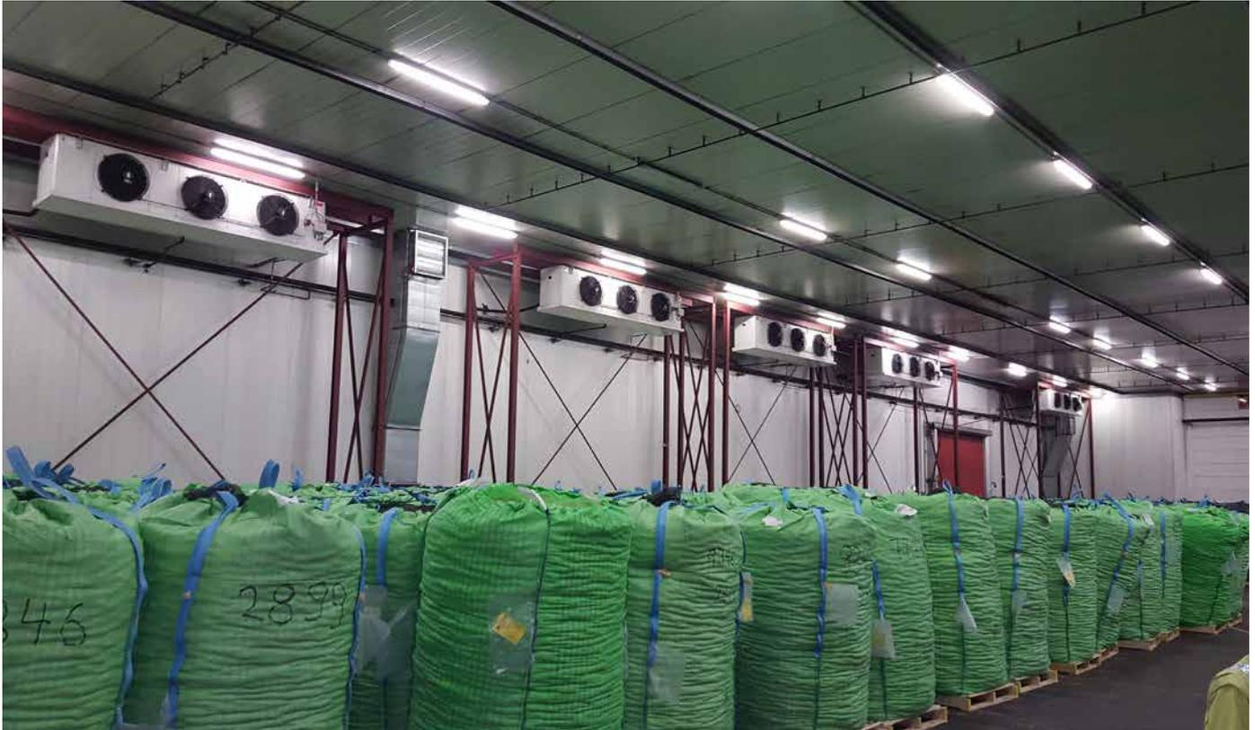
Eine große Herausforderung der Modernisierung waren die unterschiedlichen Lagerbedingungen und Temperaturen in verschiedenen Kühlräumen, die mit insgesamt acht Verbundkälteanlagen betrieben werden. *Bild: Pfannenberg*
