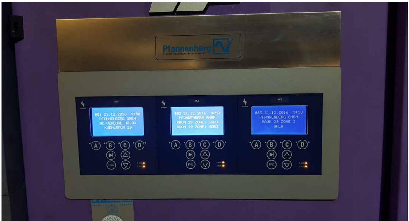
Pfannenberg hat die alte VS1000 auf eine moderne Steuerungstechnik umgerüstet, um in Zukunft eine automatische Datenübertragung zu ermöglichen und den Wartungsaufwand zu reduzieren. Bild: Pfannenberg
