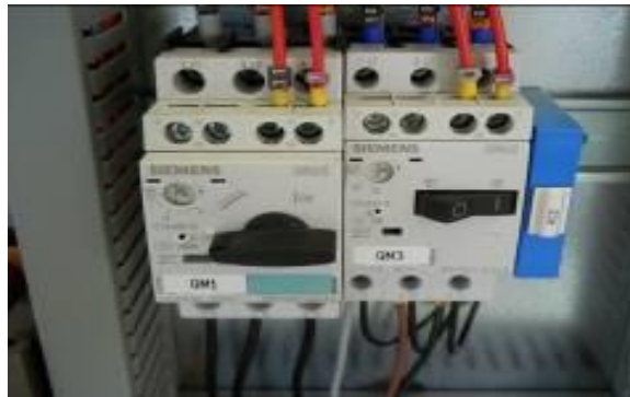
Figura 15 – Interruttore della pompa su ON
