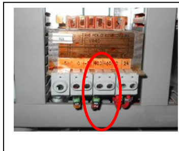
Abbildung 5 Auf 400V eingestellter Transformator
