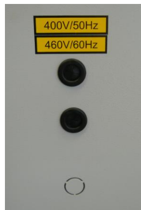
Figura 4 – Piastra per i collegamenti elettrici
