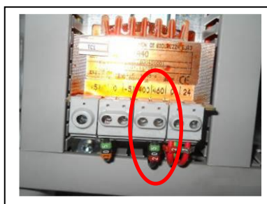
Figura 6 Trasformatore impostato a 460 V
