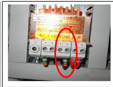
Abbildung 6 Auf 460V eingestellter Transformator
