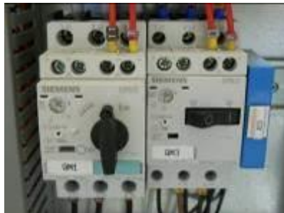
Abbildung 19 – Alle Trennschalter auf ON
