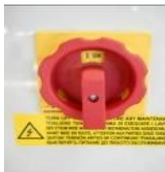
Abbildung 16 – Hauptschalter auf ON
