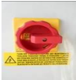
Figura 7 – Interruttore generale OFF
