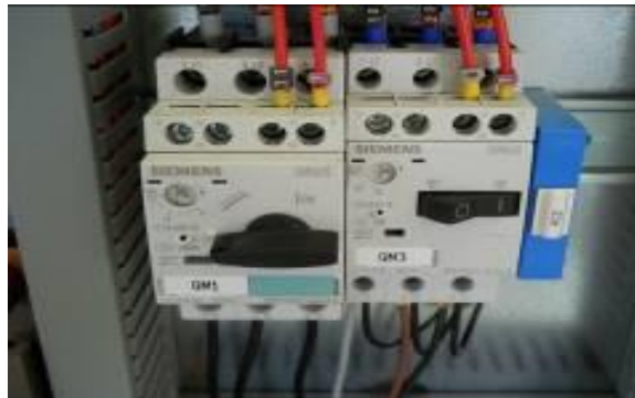
Abbildung 15 – Pumpenschalter auf ON
