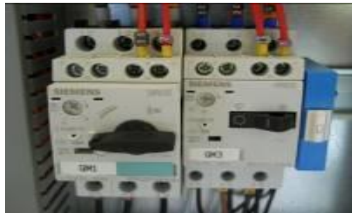
Figura 8 – Interruttori di circuito OFF
