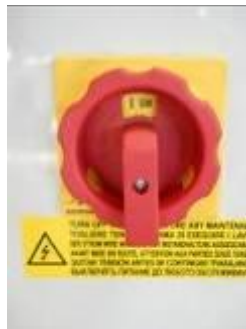
Figura 16 – Interruttore generale su ON
