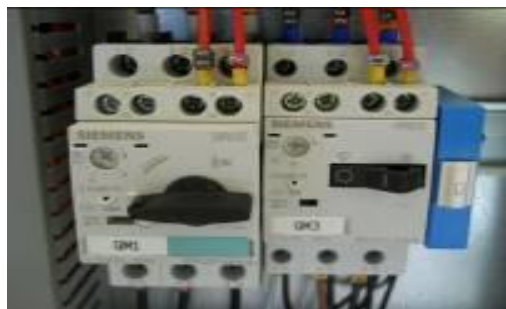
Abbildung 8 – Trennschalter OFF
