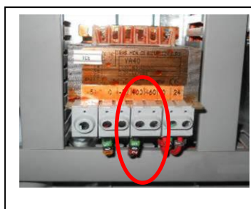
Figura 5 Trasformatore impostato a 400 V
